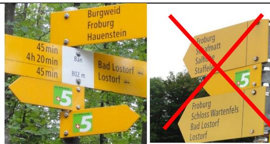
4. Abfolge am Rohr: Der Wegweiser mit der tiefsten Nummer wird zuoberst montiert, darunter die Wegweiser mit höheren Nummern bzw. mit den Routenfeldern für lokale Routen. **Ausnahme**, wenn Routenfelder bereits vorhanden sind.
