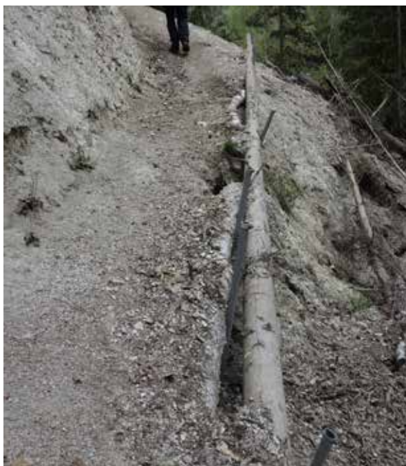
Chemin des Bisses, Grimentz-Vercorin: dégâts d'érosion résultant de l'utilisation intensive par les amateurs de VTT.
