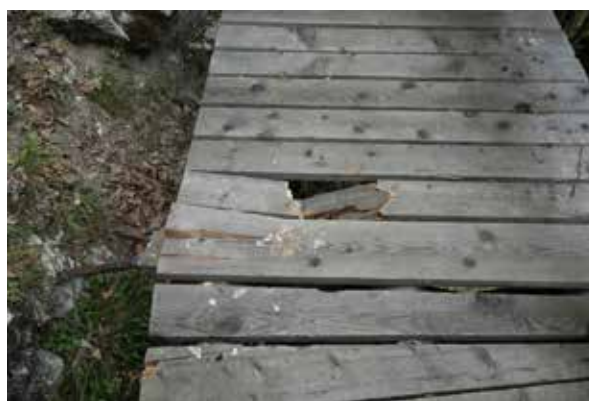
Chemin des Bisses, Grimentz-Vercorin: cette passerelle en bois endommagée est le signe visible d'une chute de pierre. L'information donnée sur ce tronçon de chemin concernant ce risque est insuffisante.
